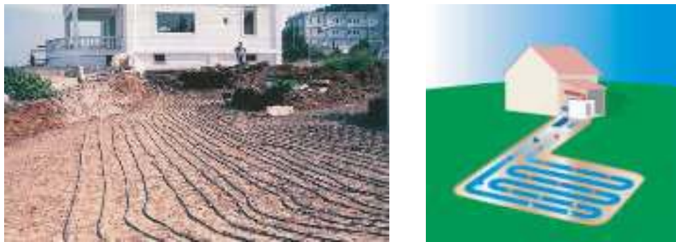
Εικόνα 5.6: Εγκατάσταση Γ.Α.Θ. με οριζόντιους Γ.Ε.Θ
