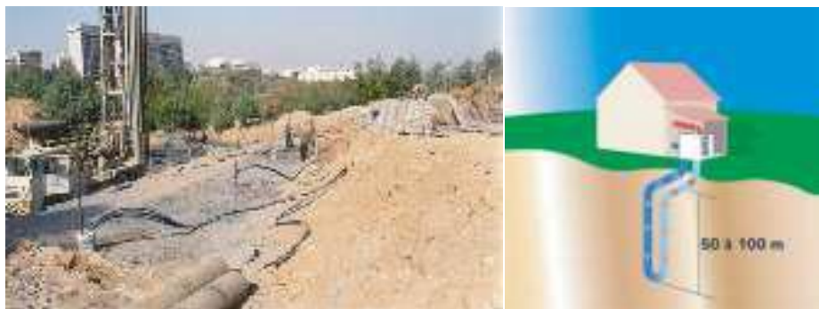
Εικόνα 5.6: Εγκατάσταση Γ.Α.Θ. με κατακόρυφους Γ.Ε.Θ
