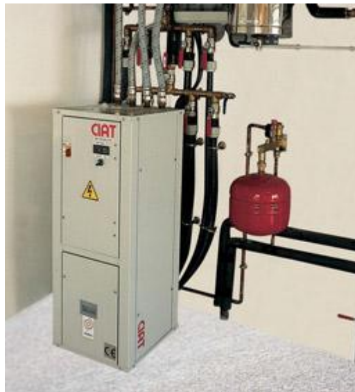
Εικόνα 5.9: Γεωθερμική Αντλία Θερμότητας
